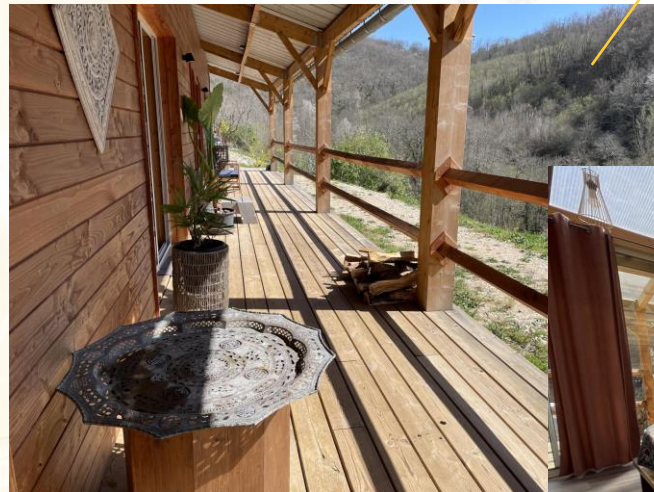
La coursive desservant les chambres d'hôtes
